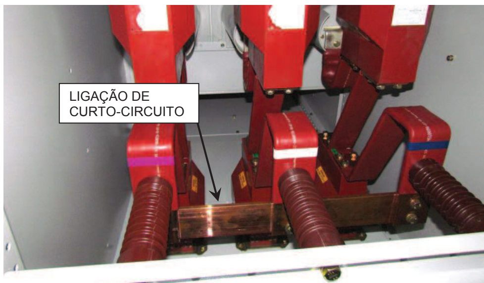
Fotografia 2: Detalhe da ligação de curto-circuito antes das aplicações de corrente no circuito principal.
