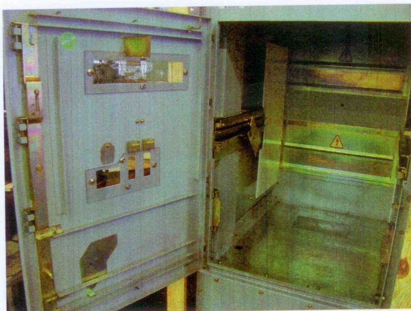
Figura 2 – Vista interna da porta e compartimento do disjuntor
