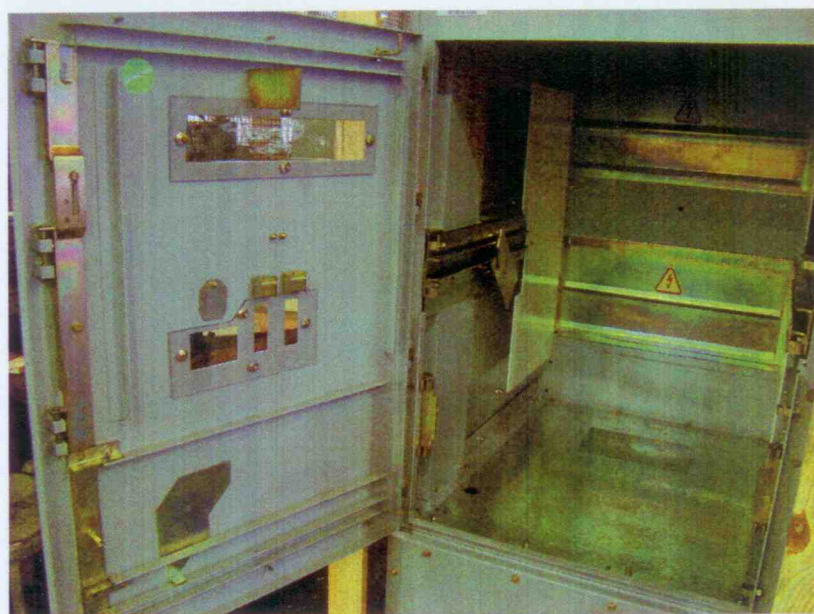
Figura 3 – Vista interna da porta central e compartimento do disjuntor
