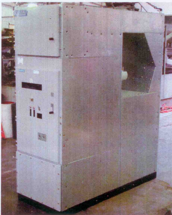
Figura 1 – Cubículo de média tensão módulo de 800 QTSIEM
