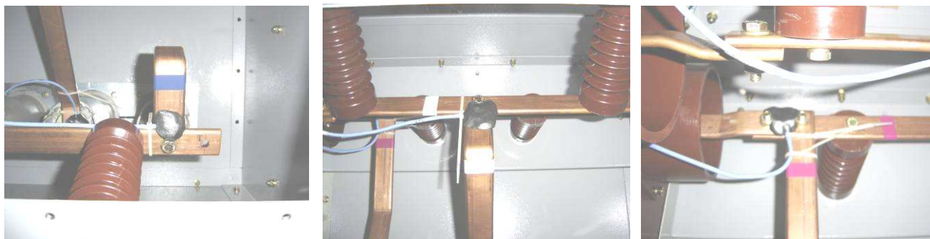
Fig.02 – Localização das sondas T_1 , T_2 , e T_3 , respectivamente.
