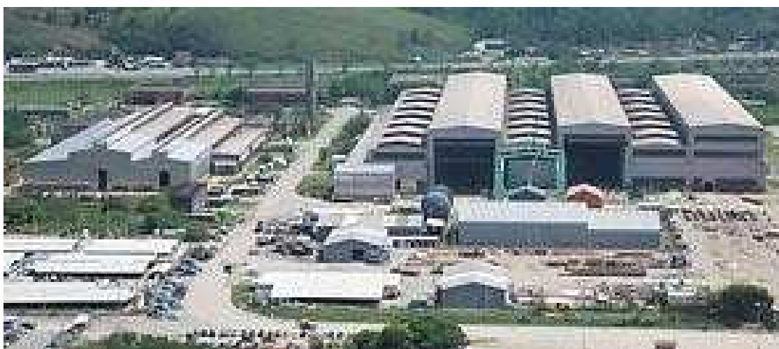
Figura 1 - Foto Geral da Unidade de Fábrica NUCLEP
