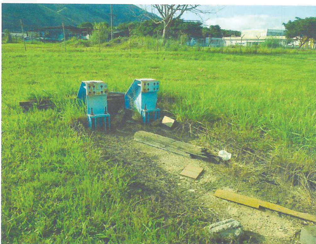
Figura 12 – Limitadores executados (parachoque)
