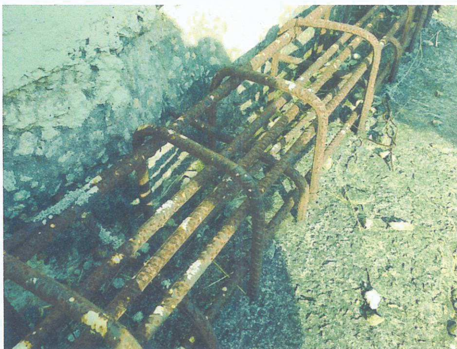
Figura 2 – Foto tirada na visita técnica da região não concretada da viga de rolamento
