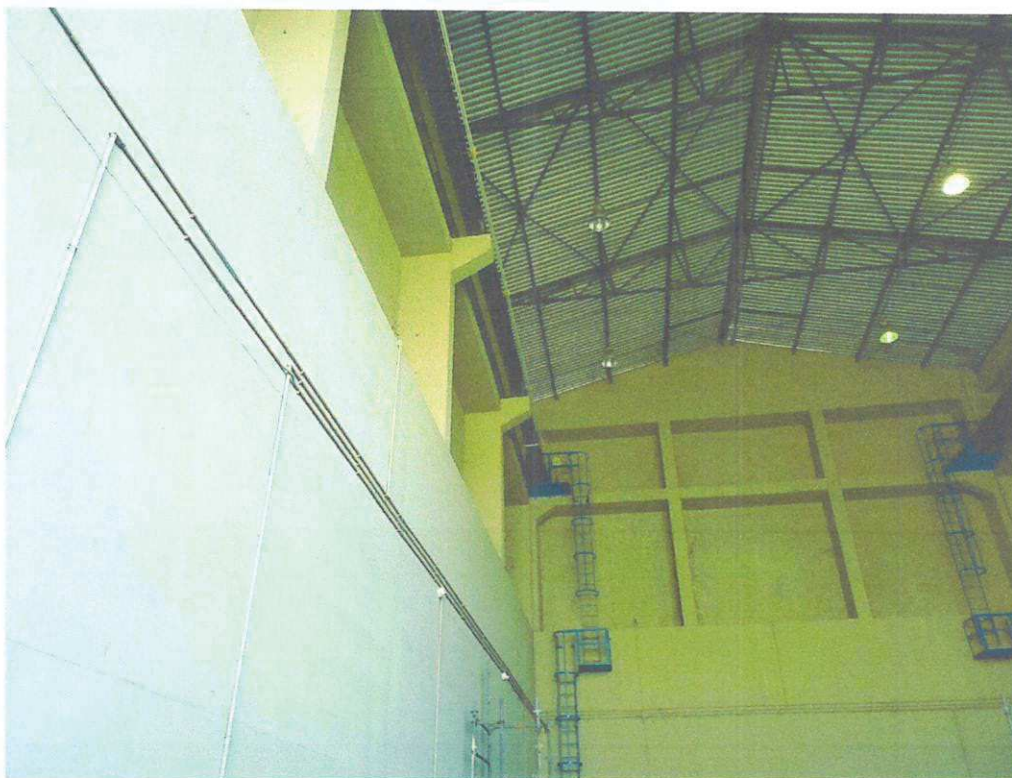
Figura 4 – Estrutura de cobertura
