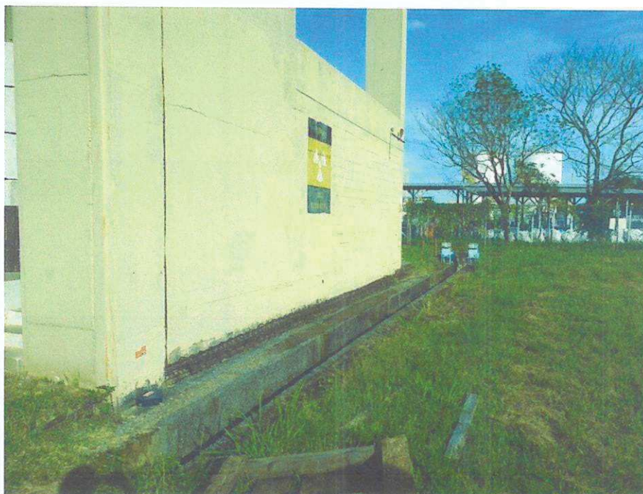
Figura 6 – Viga de rolamento
